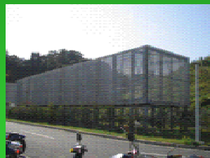
クーリングタワーによる潜熱化
